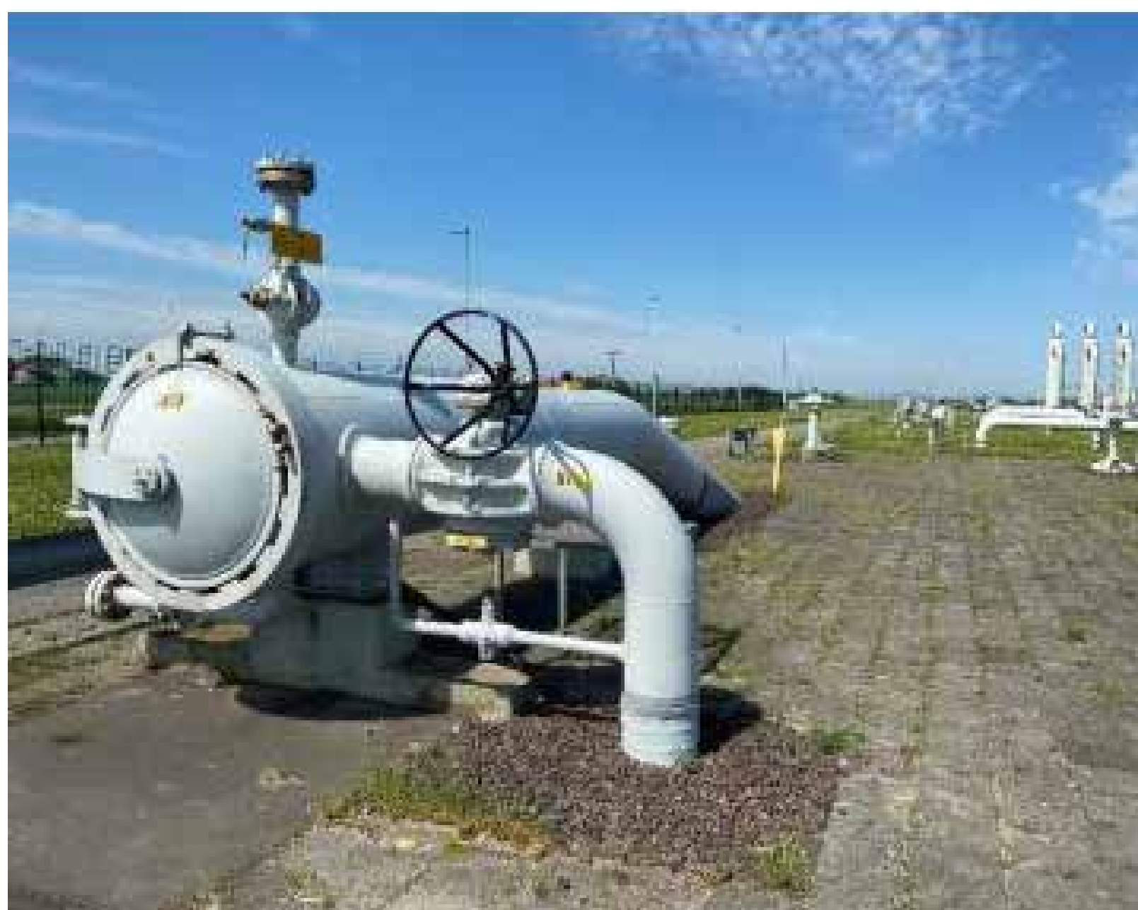
Pigging: inwendig inspecteren van de leidingen
