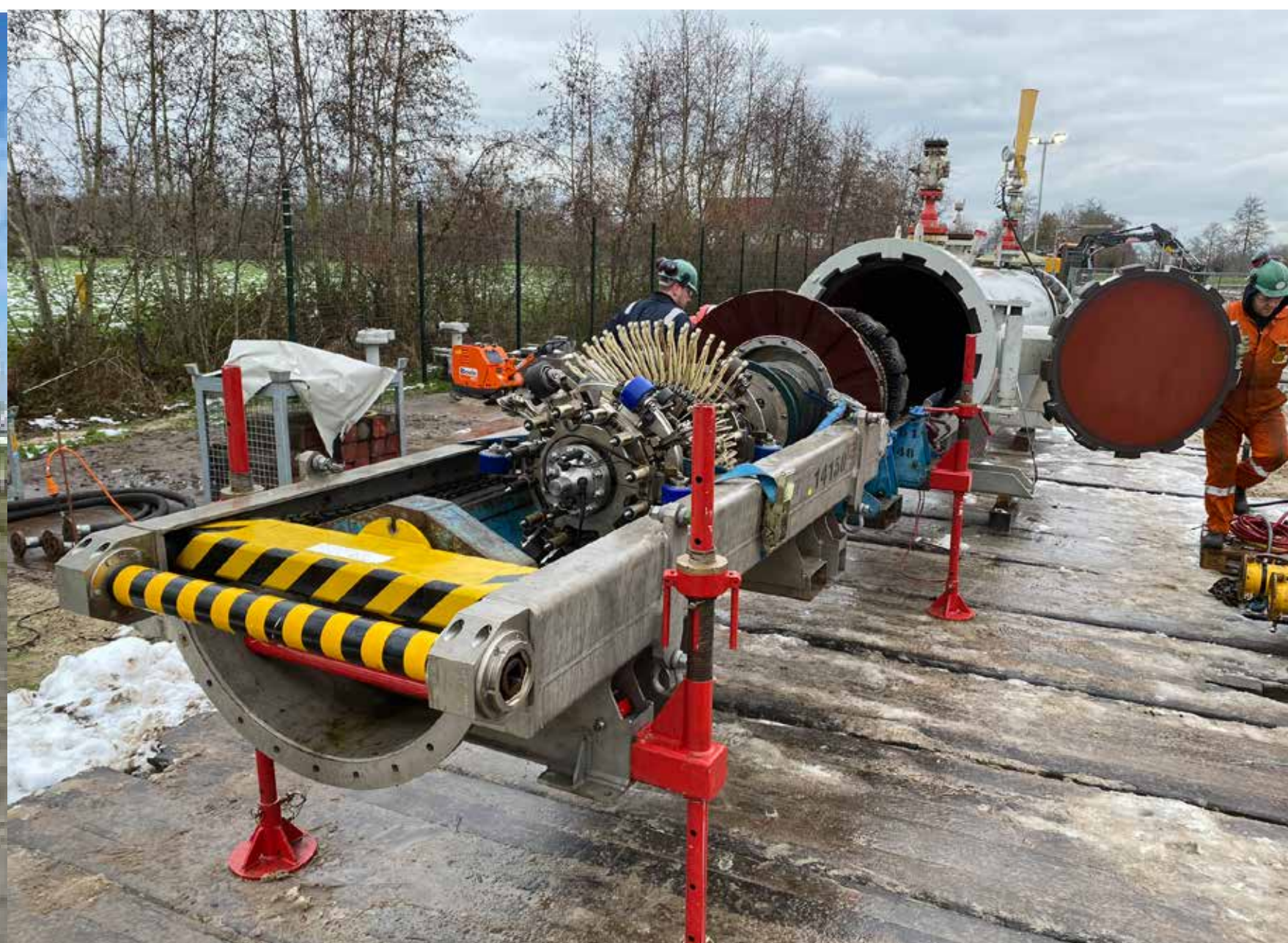
Pigging: inwendig inspecteren van de leidingen
