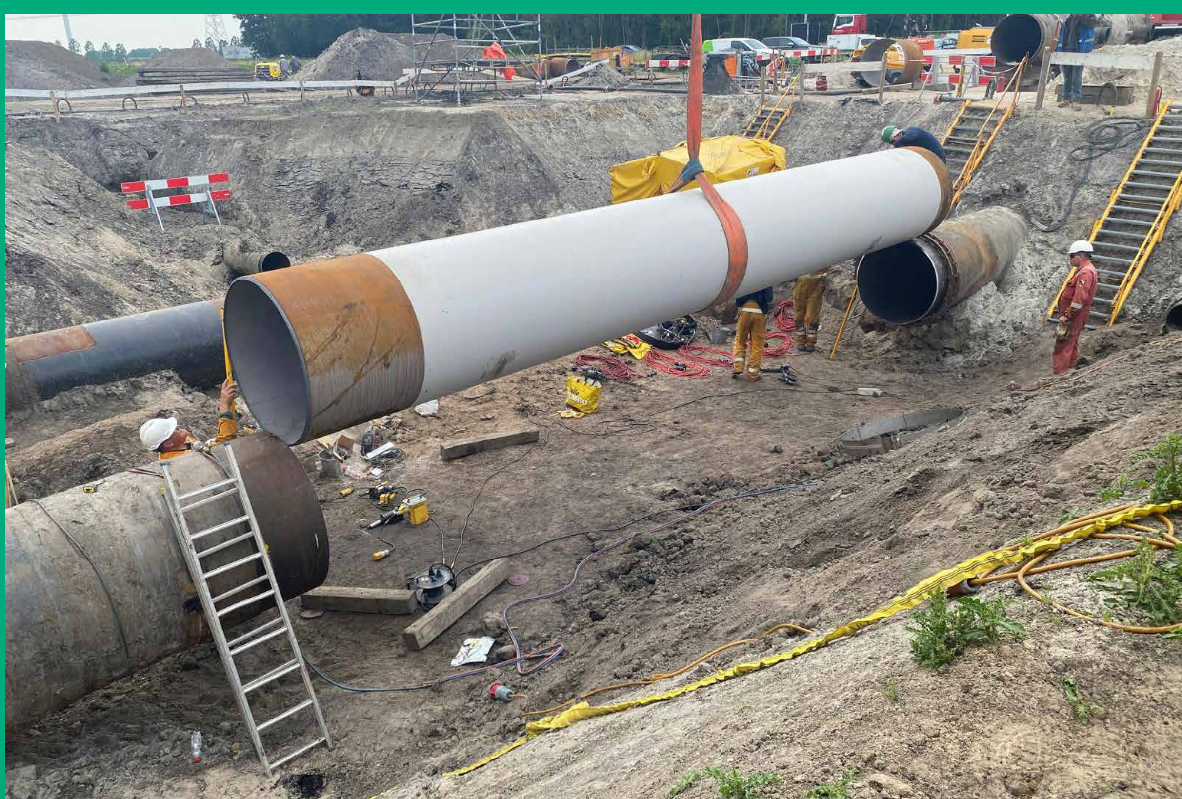
Nieuw leidingdeel plaatsen
