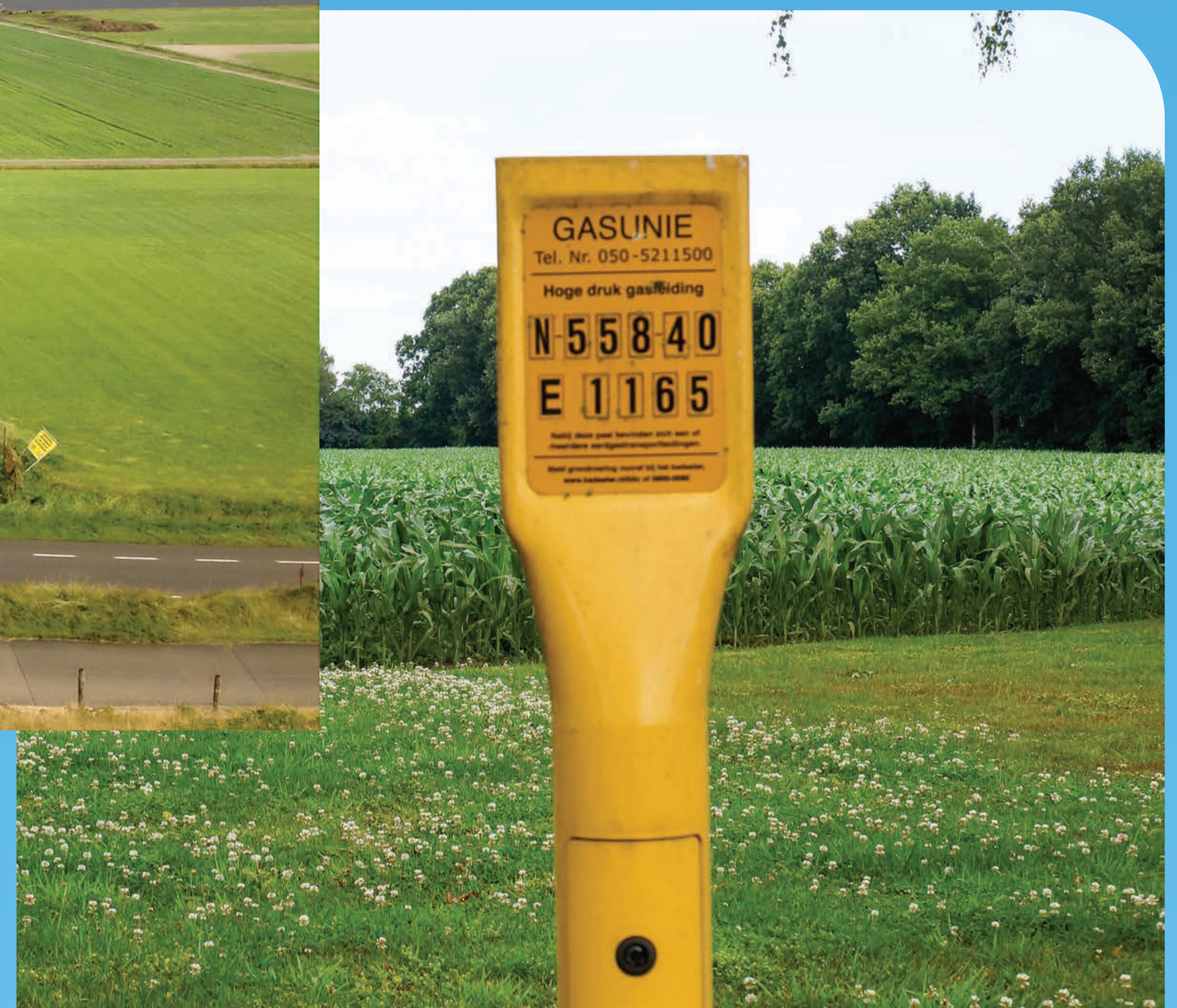
Gasunie-paaltje in landschap na aanleg leiding
