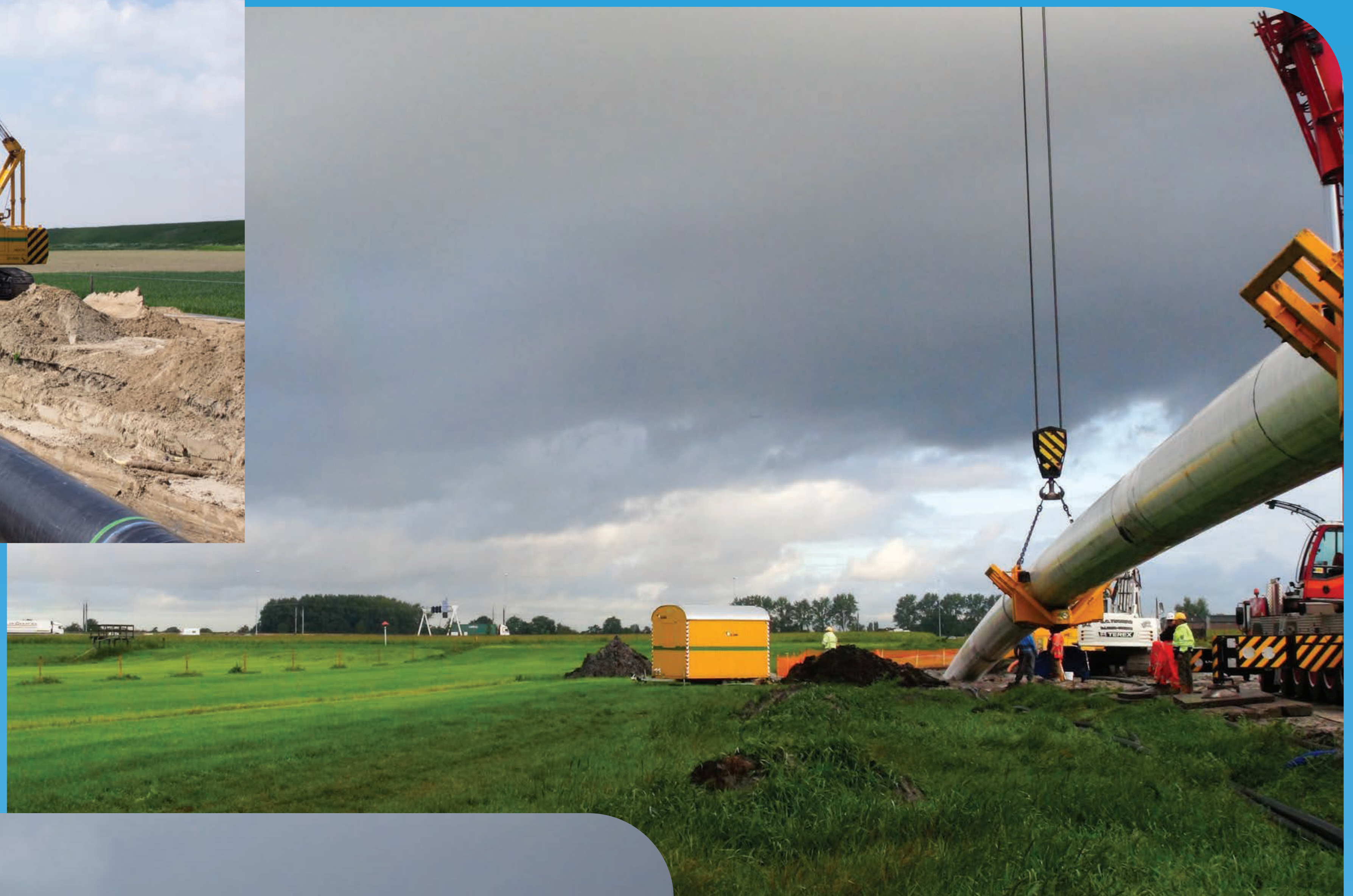
Aanleg leiding met horizontaal gestuurde boring
