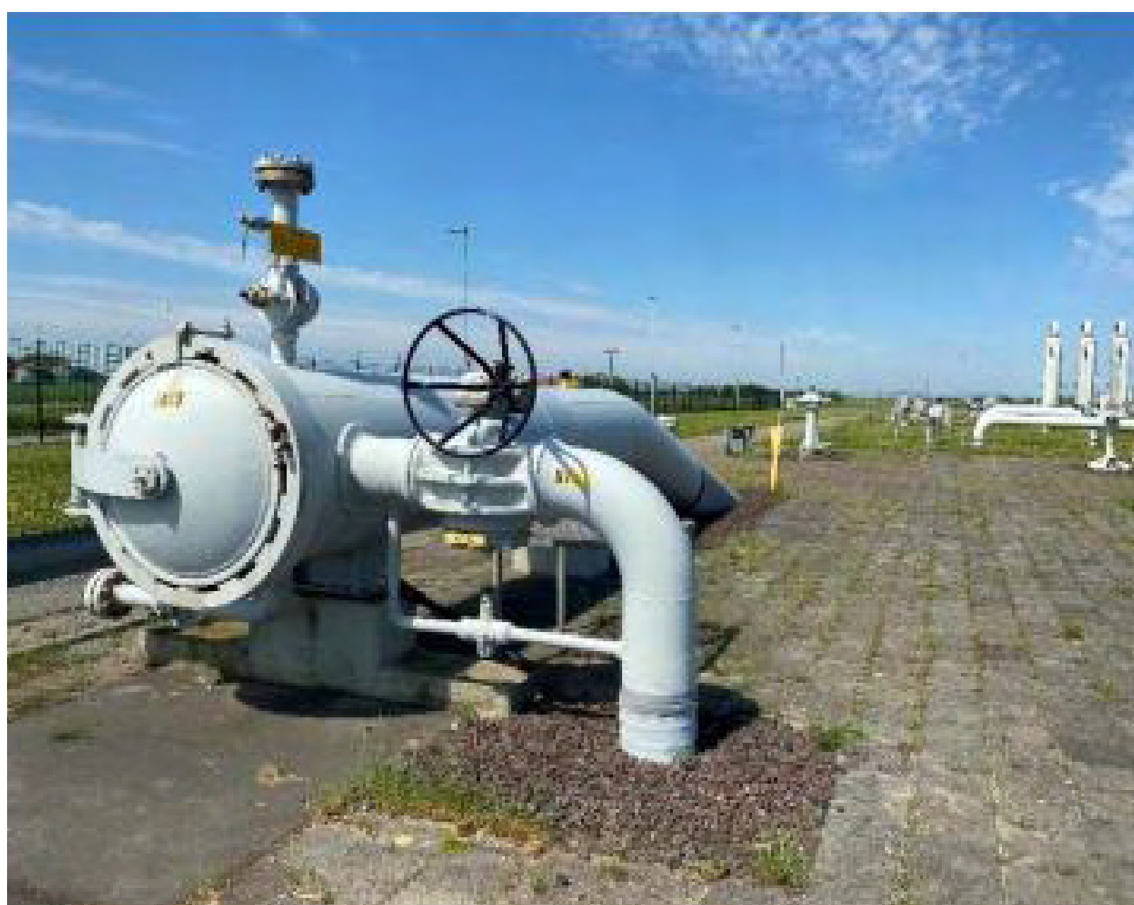
Pigging: inwendig inspecteren van de leidingen
