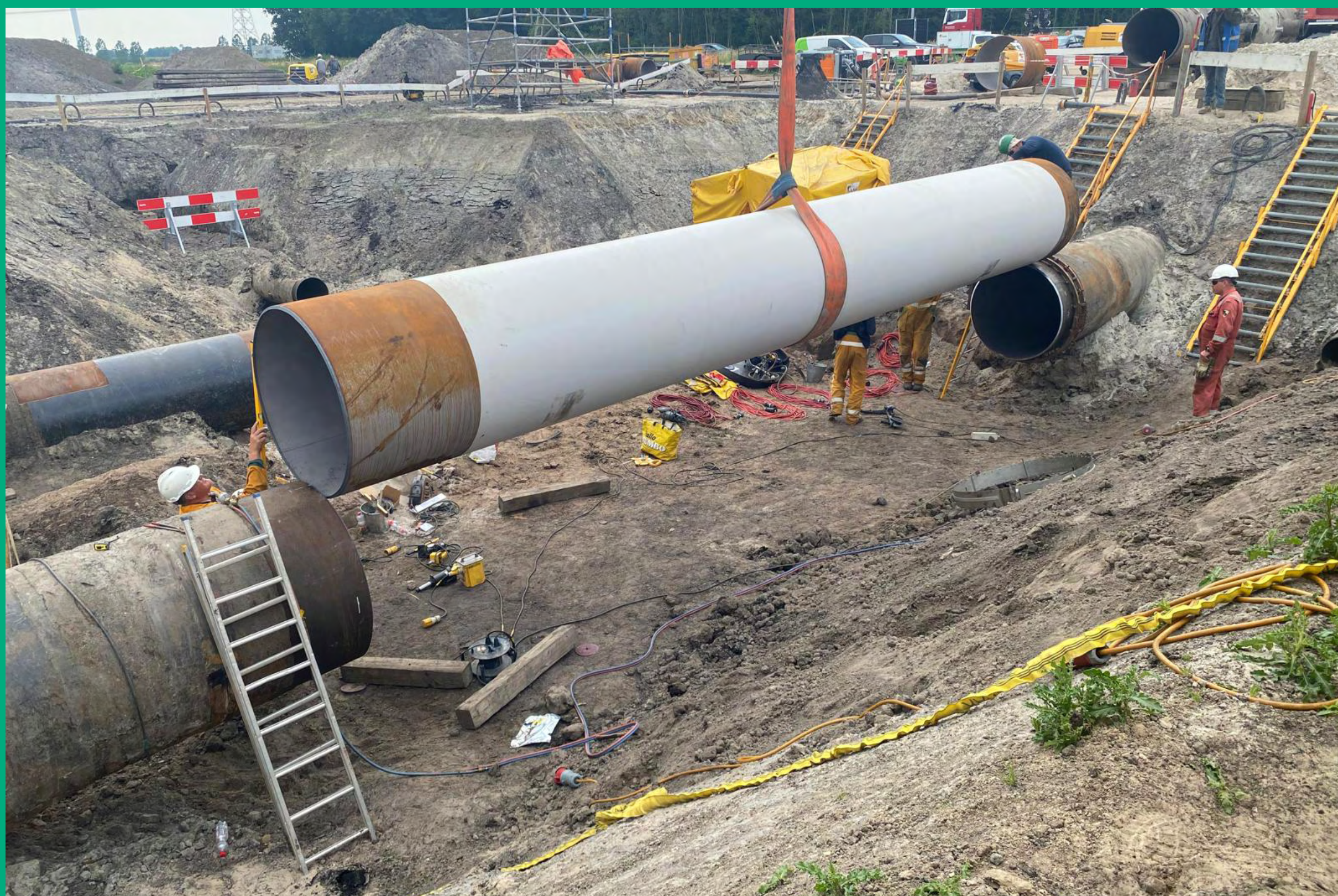
Nieuw leidingdeel plaatsen
