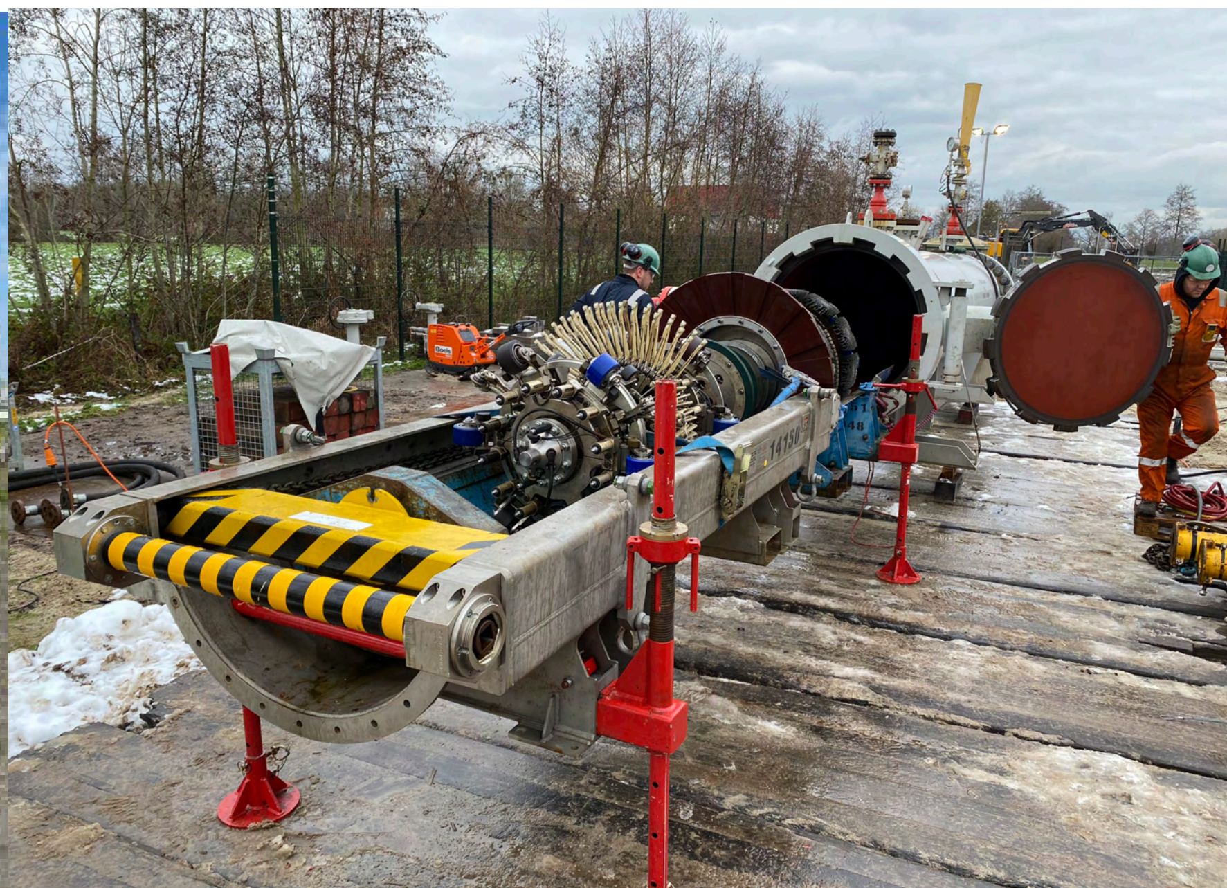
Pigging: inwendig inspecteren van de leidingen
