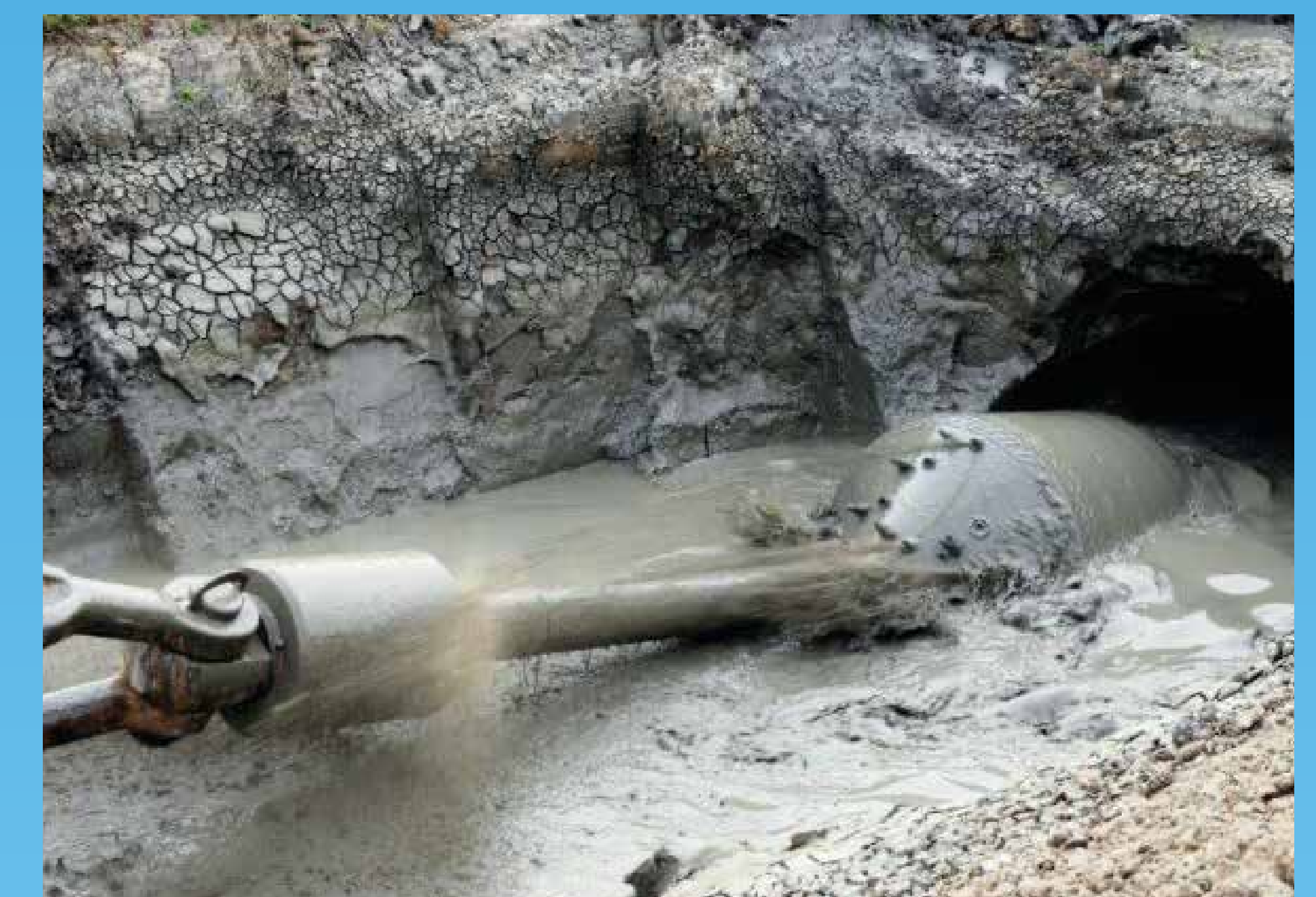
De buis komt boven de grond nadat deze vanaf de andere kant ingetrokken is.
