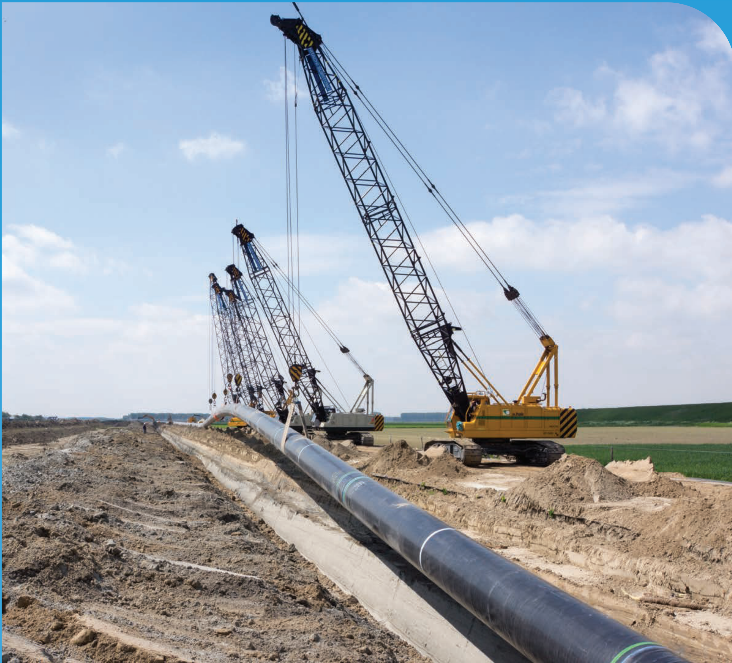
Aanleg leiding met open ontgraving
